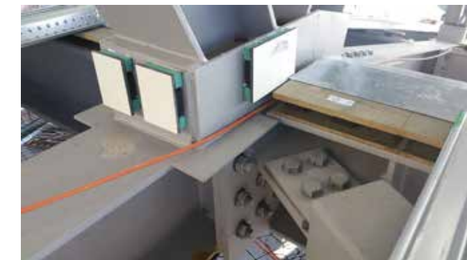
Over de dwarsbalken, waarop de ComFlor-platenvloer van de bioscoopzalen worden bevestigd, zijn geluidsisolerende CDM ISO SEB oplettingen gelegd.
